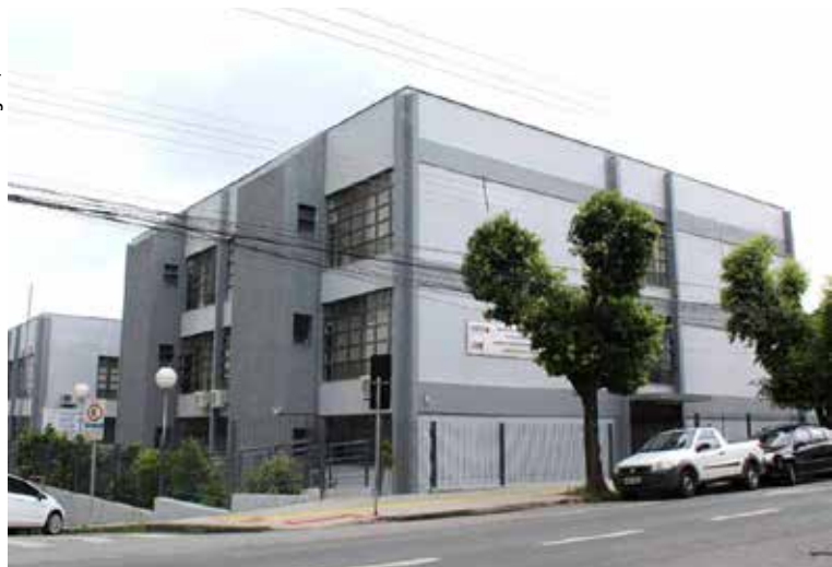
A nova sede da ARE/Divinópolis funciona no terceiro andar do edifício
